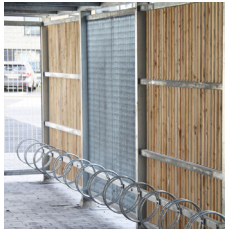
Integrerede stativer monteret mellem søjler.
