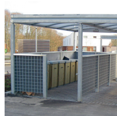
Miljøstation beklædt med eternit og rionet til espalier
