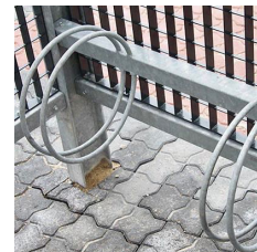
Keep cykelstativer monteret mellem søjler i overdækning.
