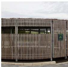
Circular overdækning her anvendt til cykelparkering.
