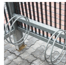
Keep overdækning med integrerede stativer.
