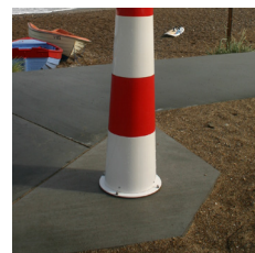
Lighthouse pullerten er fæstnet på belægning med stålramme.
